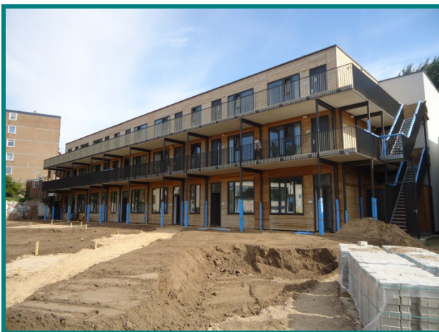
Spoorzone leveren HSB Opdrachtgever: Van Dijk Groep
