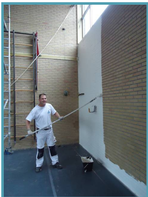
Start werkzaamheden gymzaal “de Kamp”Hijken. Opdrachtgever: Gemeente Midden Drenthe
